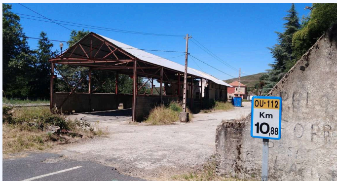
Acceso a la estación de Cerdedelo (Laza). Foto: Estevoaei · CC BY-SA 4.0 · P03.
